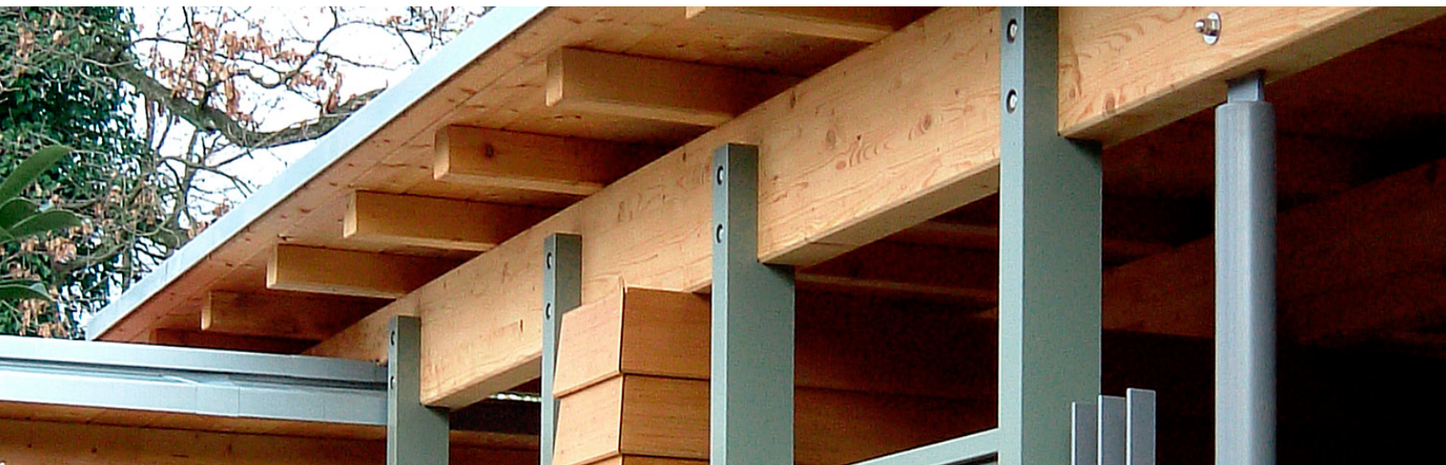
Foto: Qigong-Haus in Mönchengladbach (Architekt: Wilfried Kaufmann, Schwalmatal)
