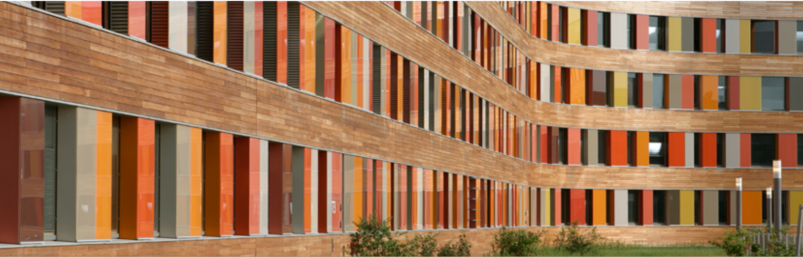
Foto: Umweltbundesamt in Dessau (Sauerbruch Hutton Architekten, Berlin)
