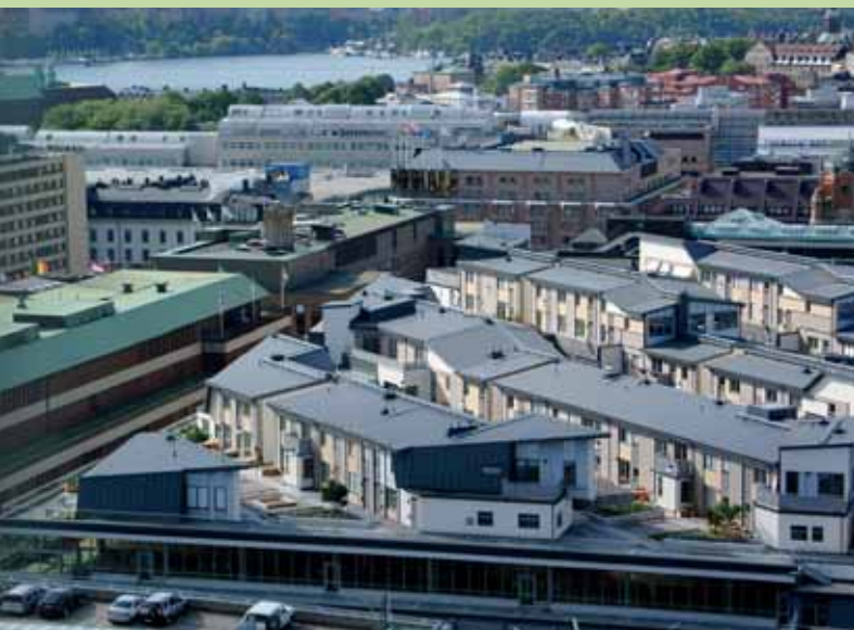
Aufstockung von Reihenhäusern auf einem Verwaltungsgebäude in Stockholm.
