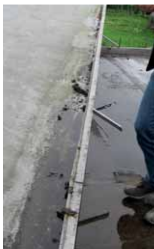
Abb. 4: Entwässerung nur nach Rückstau
