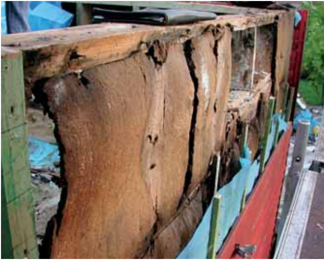
Abb. 9: Dampfbremsfolie auf der gesamten Außenseite der Außenwand und Attika Quelle: [Martin Mohrmann, 2006]
